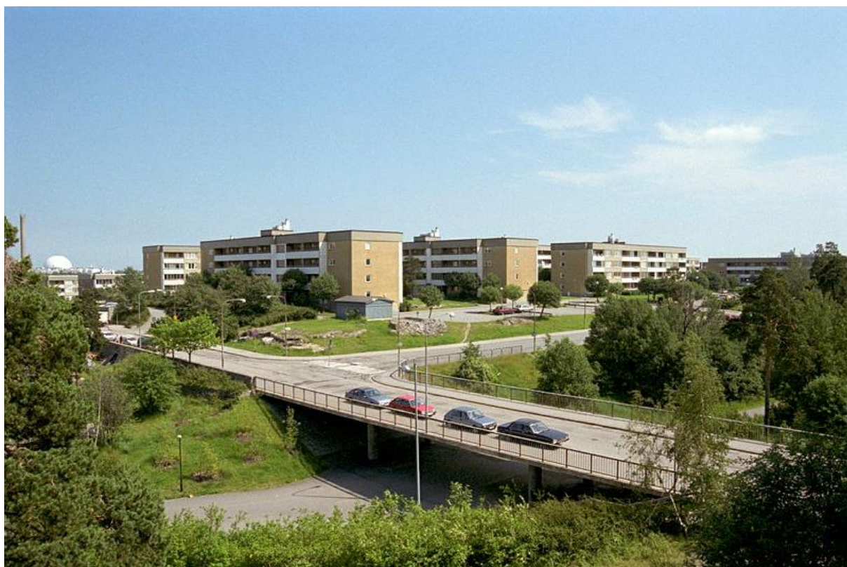
Figur 21. Vy från nordväst över viadukten vid Östbergabackarna mot kvarteret Spinnsidan. I fonden till vänster skymtar Globen. Foto från 1997. Källa: Stockholms stadsmuseum.
