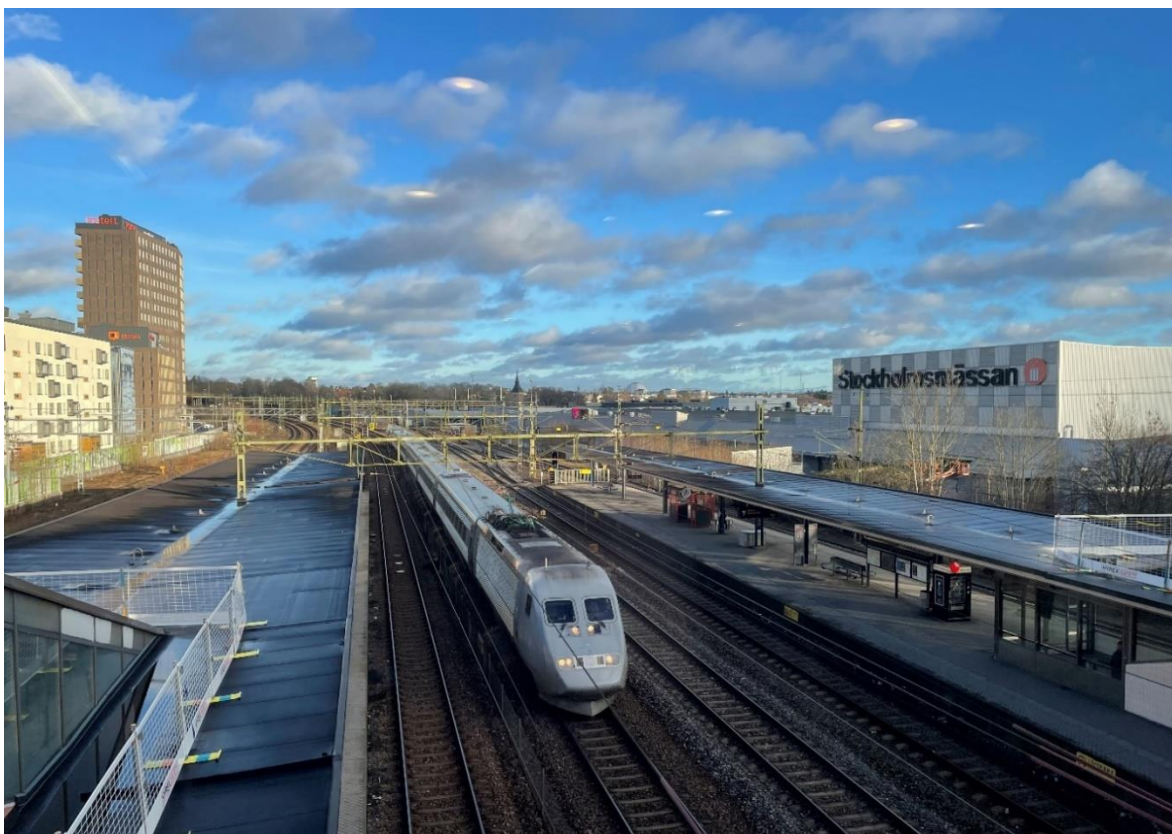
Figur 28. Spårområdet i Älvsjö, med Stockholmsmässan till höger. Foto: Klara Edvardsson, Sweco.
