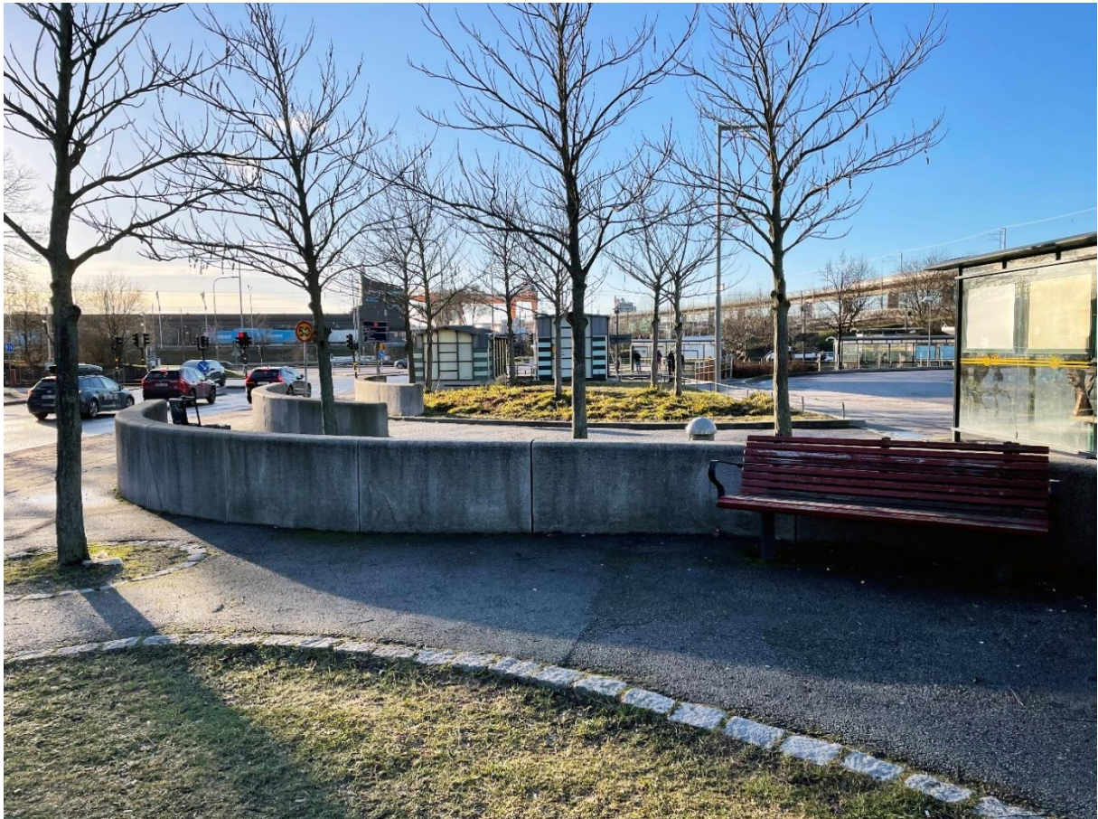
Figur 25. Intill busstorget i Årstaberg finns en liten park med bänkar och murar. I bakgrunden syns två teknikbyggnader. Foto: Klara Edvardsson, Sweco.
