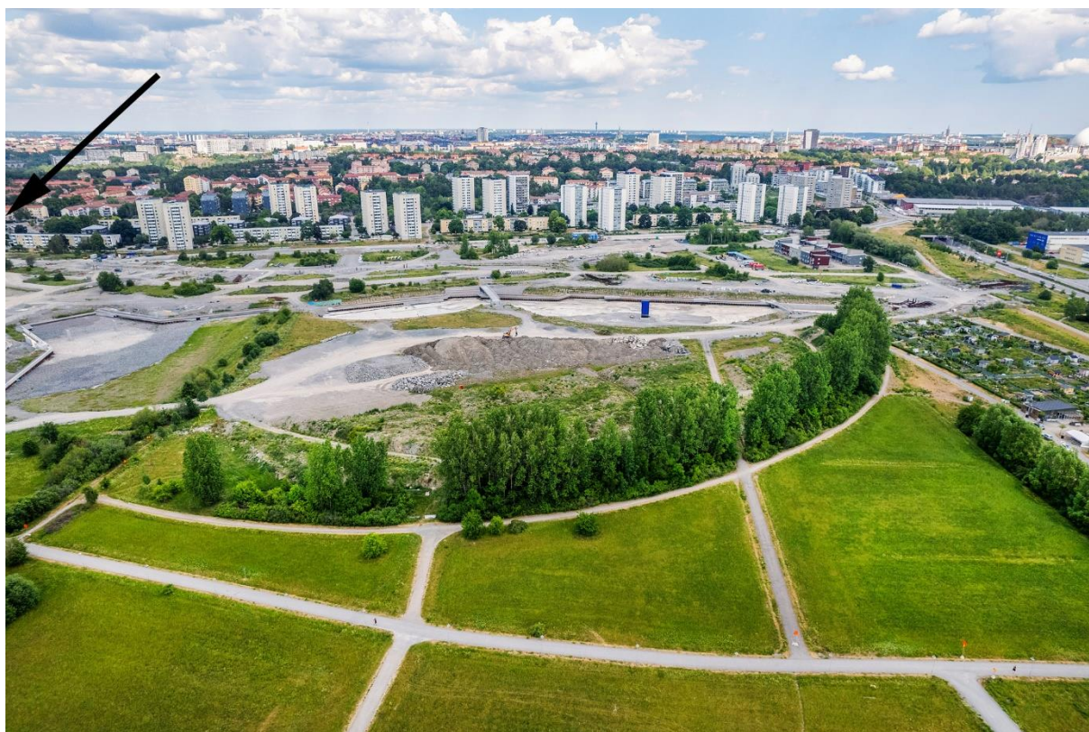
Figur 11. Stora delar av Årstafältet är idag en byggarbetsplats. Den nya tunnelbanestationen kommer att ligga i ett nytt kvarter, nära den befintliga bebyggelse som syns i fotots övre vänstra kant, se svart pil i fotot.
